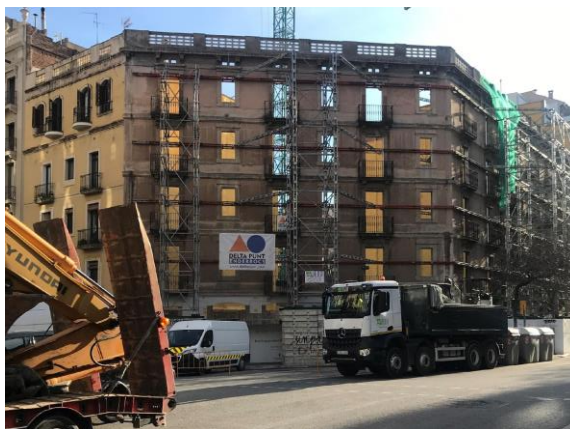
Edifici al carrer d'Enric Granados. 2021
