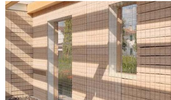
En el proyecto de la escuela el uso del cáñamo se favorece como **elemento fundamental de la envolvente**, en la cubierta como aislante (como panel de fibra), y sobre todo en el paramento vertical, donde constituye el alma de la fachada.
